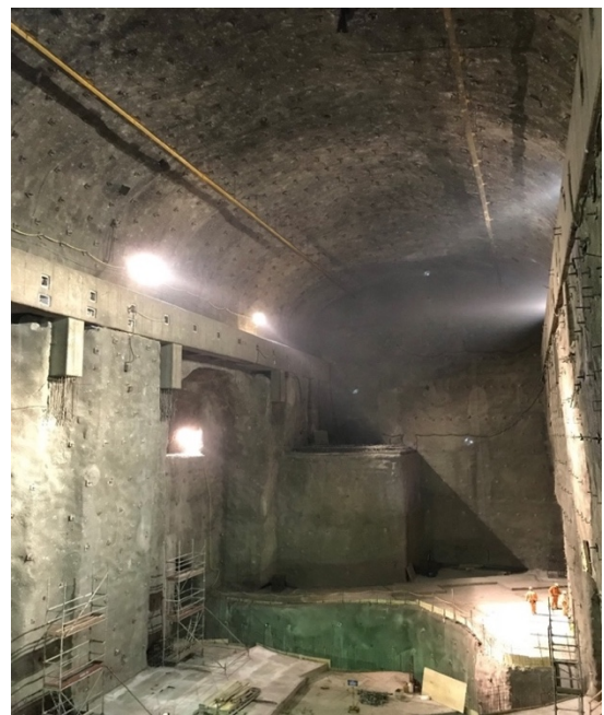
Figure 2. Powerhouse Cavern Las Lajas.
