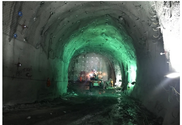
Figure 1. Drill & Blast Alfafal Tailrace Tunnel L10-A1.
